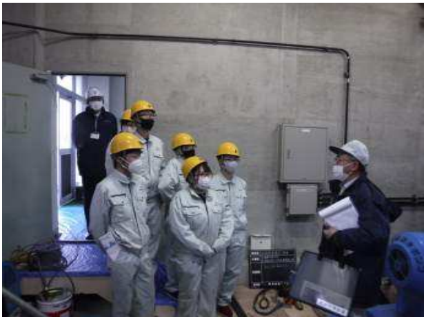
揚水ポンプ整備状況見学
