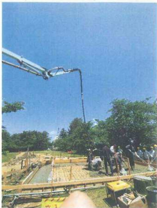
5/24 コンクリート打込工事
