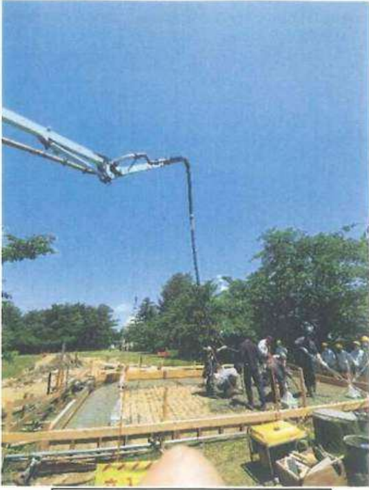
5/24 コンクリート打込工事
