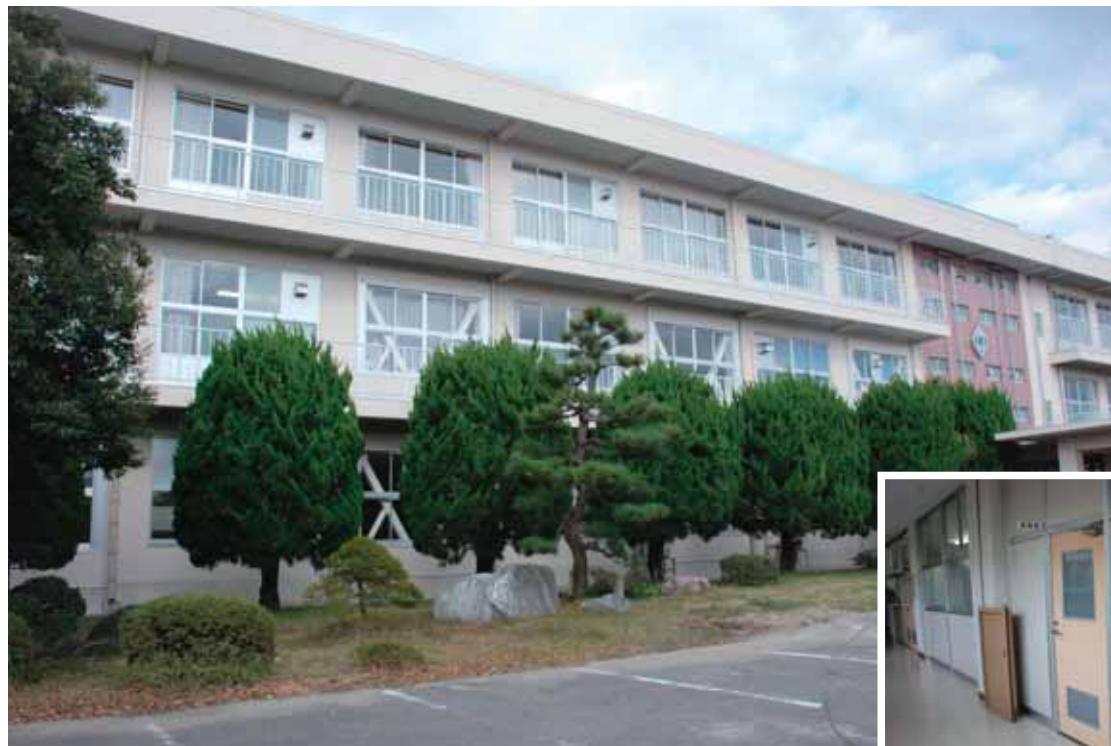
補強工事が完成した校舎
