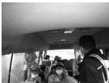
変電所見学(車中にて説明)
