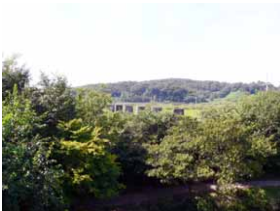
破壊された橋
